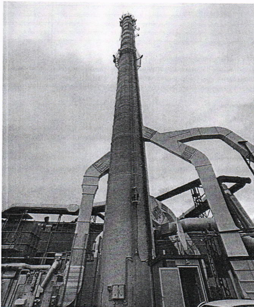
Zdjęcie 1 Badany obiekt
