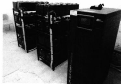
Zdjęcie 3 System podtrzymania napięcia UPS
